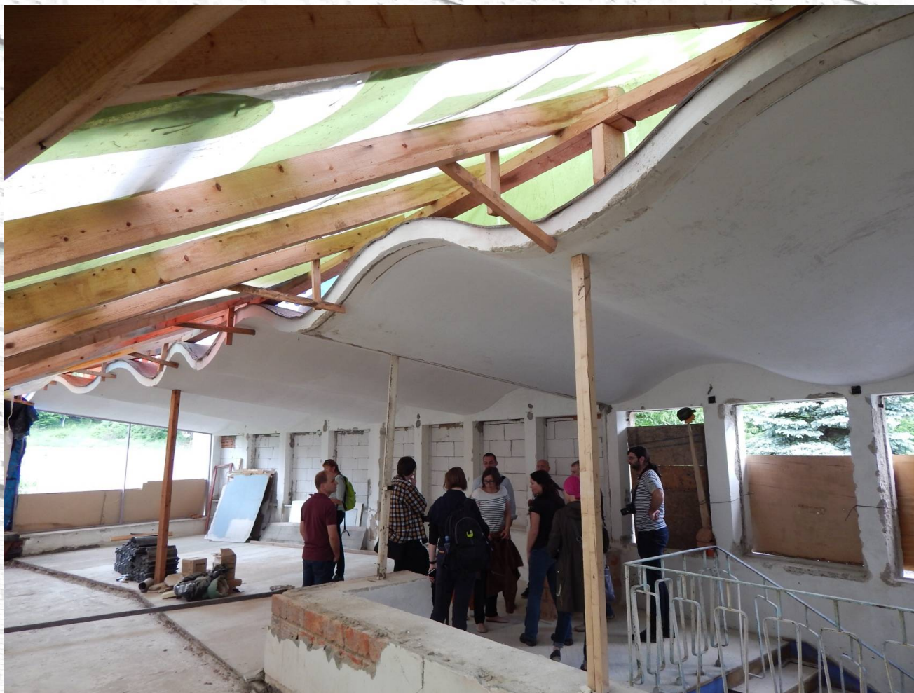
TERASA ZČÁSTI KRYTÁ ZVLNĚNOU STROPNÍ KONSTRUKCÍ
