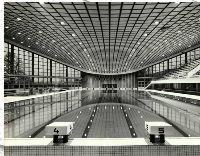
Plavecká hala - interiér
