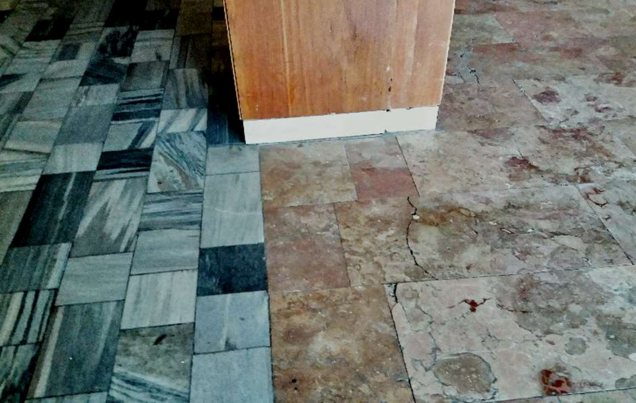
Soubor 3 věžových budov na nám. J. Curie / Šumavská materiály povrchů v interiérech
