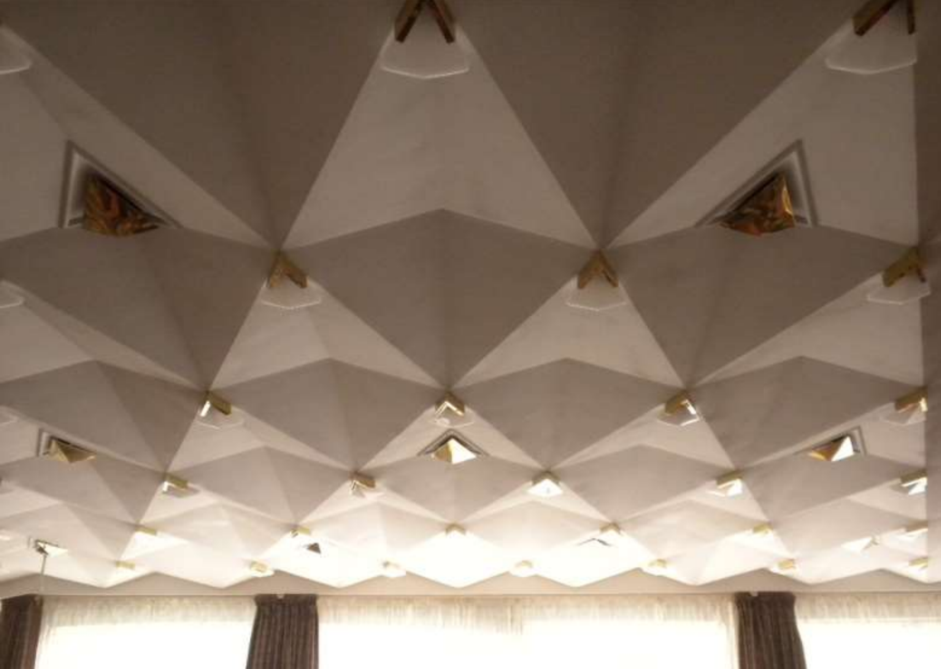
Strop kavárny s „diamantovým řezem“ , HOTEL INTERNATIONAL, Brno
