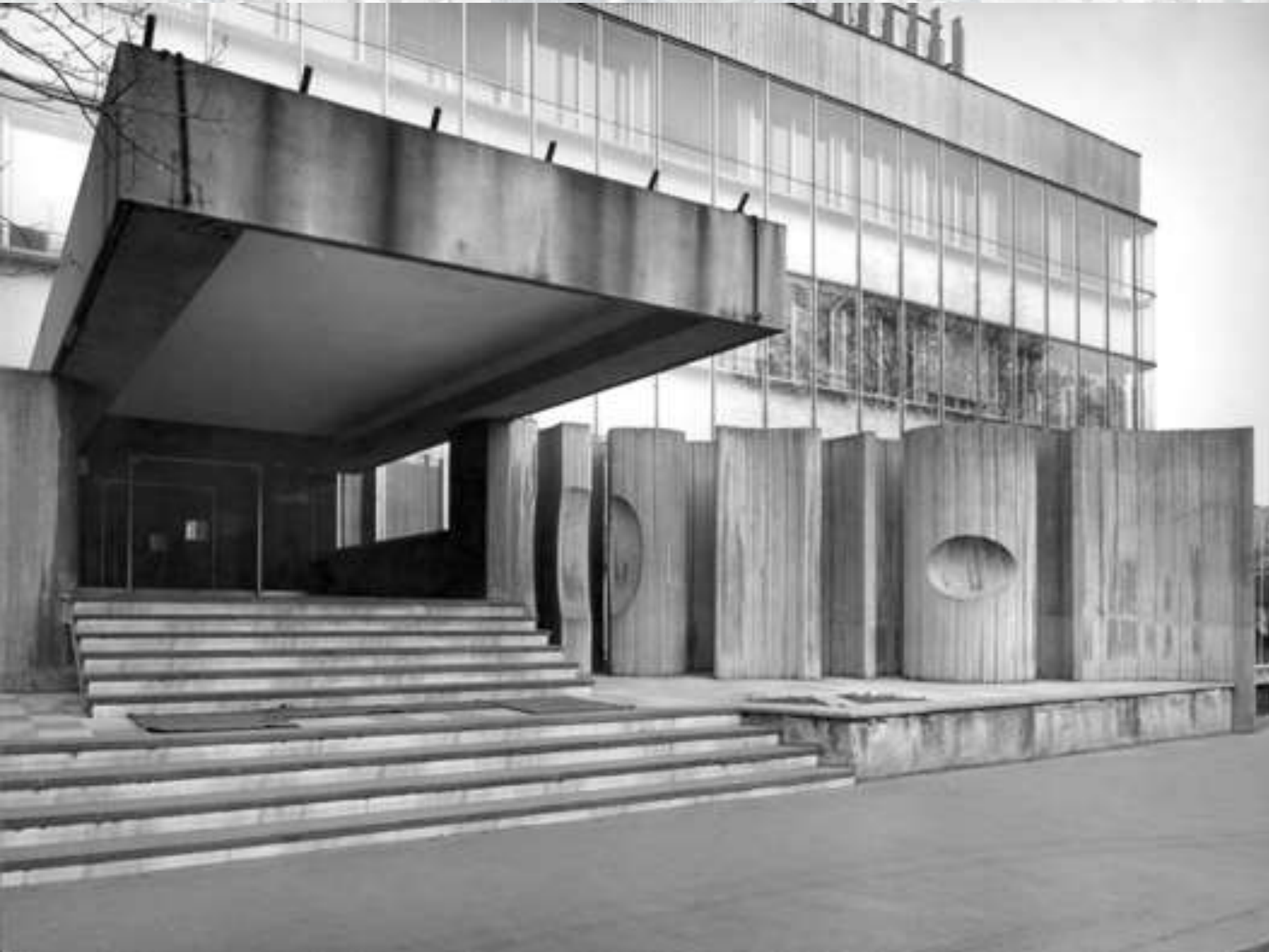
Administrativní a provozní budova Ingstav, Vídeňská, Brno Ivan Ruller, 1968 - 1970
