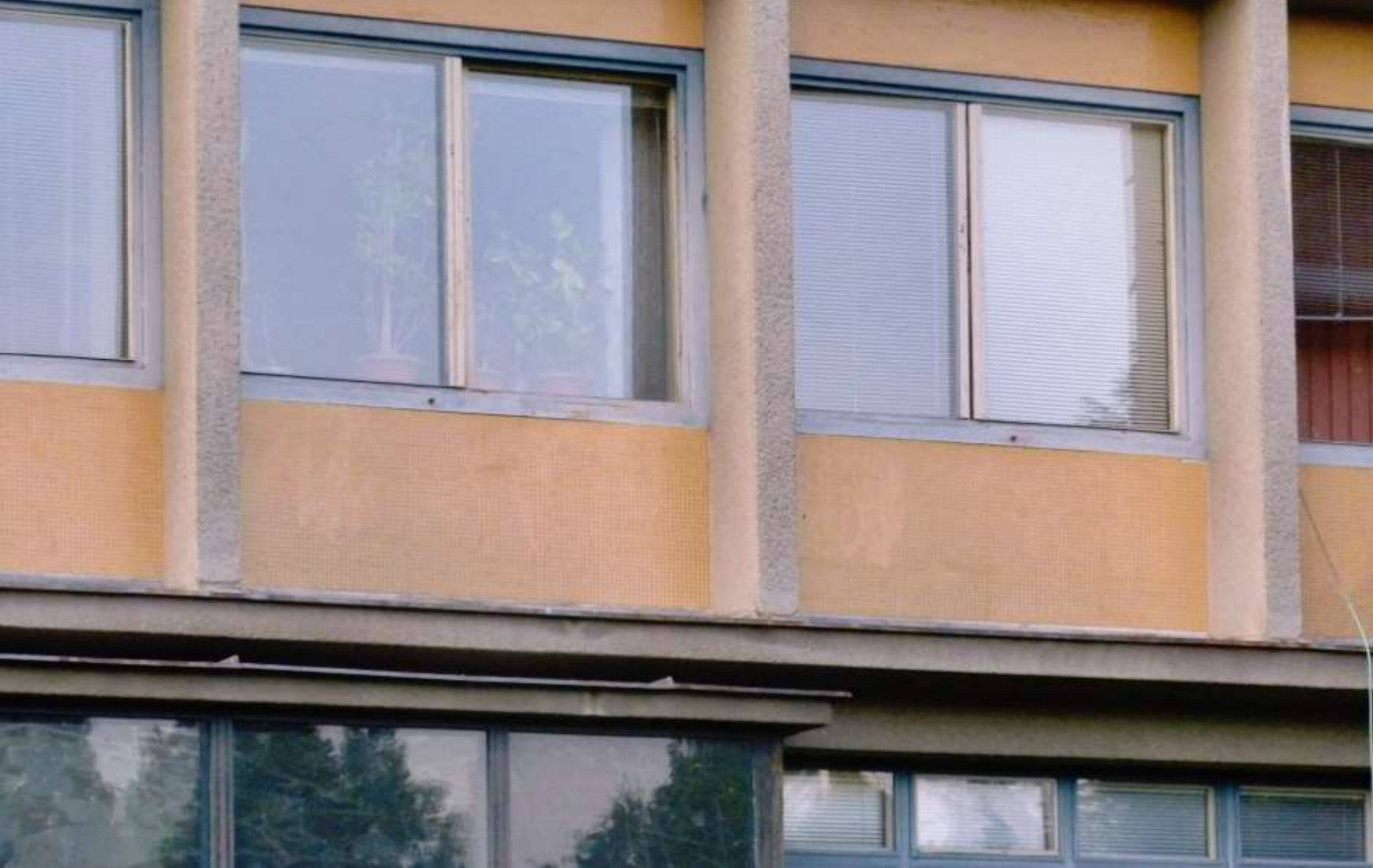
Fasáda lůžkového oddělení, Psychiatrická klinika FNsP, Brno – Bohunice
